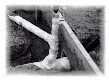
An Inexpensive, Efficient way of wrapping all pipes in concrete pour
